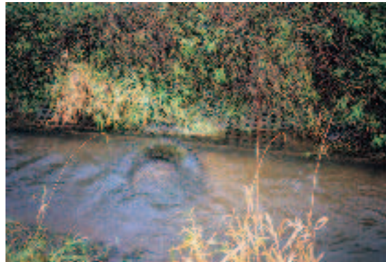
Bestand des naturfernen Verbaus des Uferbereiches der Föritz (Foto: BIW Erfurt; 1999)
