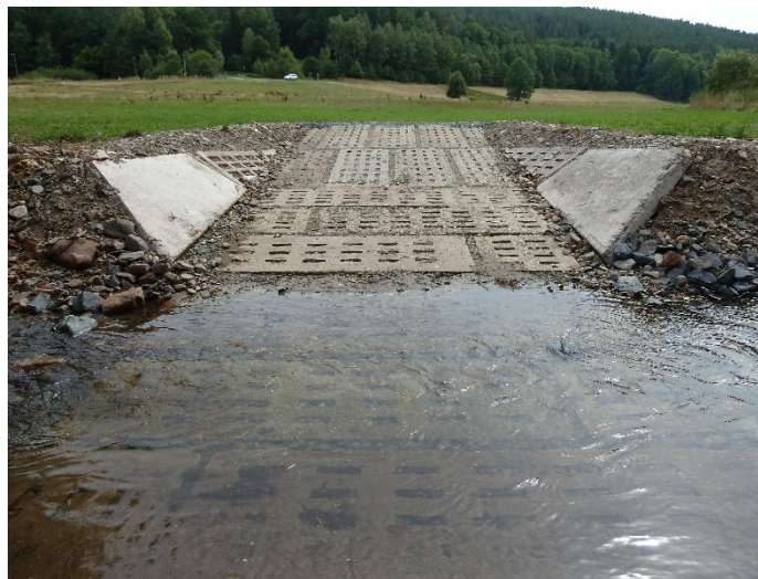
Die Stahlbetonplatten des ehem. Kolonnenwegs wurden quer zur Fließrichtung und in einem Abstand von 10 cm eingesetzt, um weiterhin Wanderbewegungen von im Flusssediment lebenden Fließgewässerorganismen zu ermöglichen. (Foto: Zweckverband Grünes Band)
