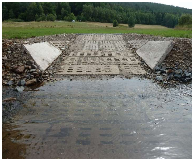
Die Stahlbetonplatten wurden quer zur Fließrichtung und in einem Abstand von 10 cm eingesetzt, um Wanderbewegungen von im Flusssediment lebenden Fließgewässerorganismen weiterhin zu ermöglichen. (Foto:
